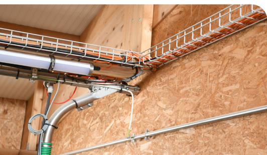
Anche i componenti dell'impianto elettrico esistente possono essere adattati con materiali ignifughi. (Immagine: SPIA)
