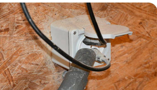
Utilizzate un aspirapolvere per rimuovere regolarmente la polvere dalle prese. (Immagine: SPIA)
