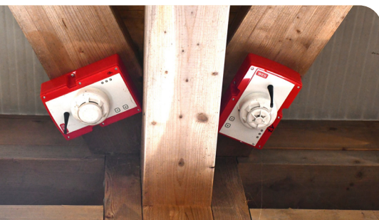
I rilevatori di fumo e di calore senza fili e protetti dalla polvere garantiscono un allarme tempestivo in caso di incendio. Possono essere installati nelle stalle esistenti senza bisogno di ulteriori misure strutturali. (Immagine: SPIA)
