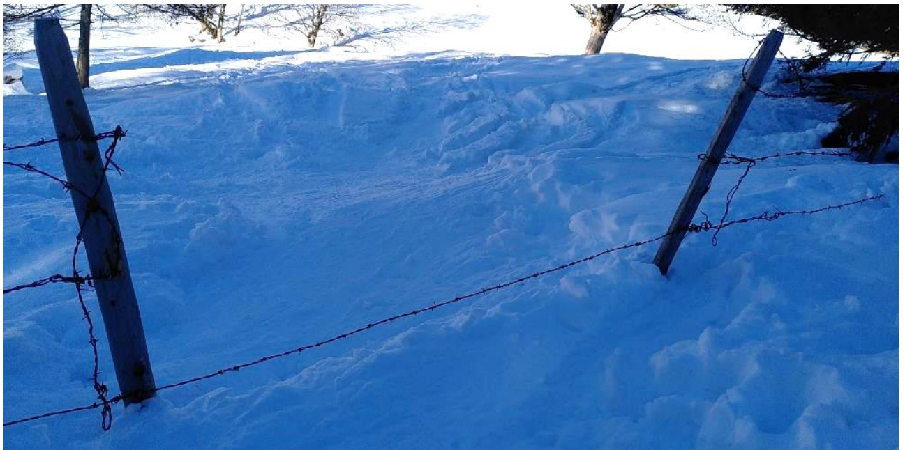
Ce passage de clôture, sur un itinéraire de ski de randonnée, illustre clairement le risque de blessures que peuvent occasionner des fils qui n'auraient pas été déposés complètement à terre. (Photo : CAS)
