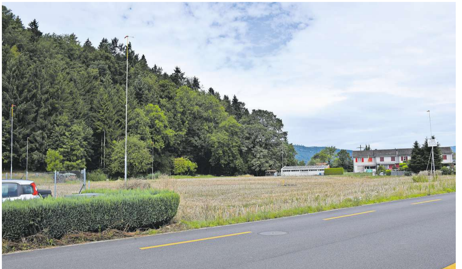
Auf der Parzelle an der Sägetstrasse zeigen die Profile schon die Dimensionen des geplanten Gebäudes an.
