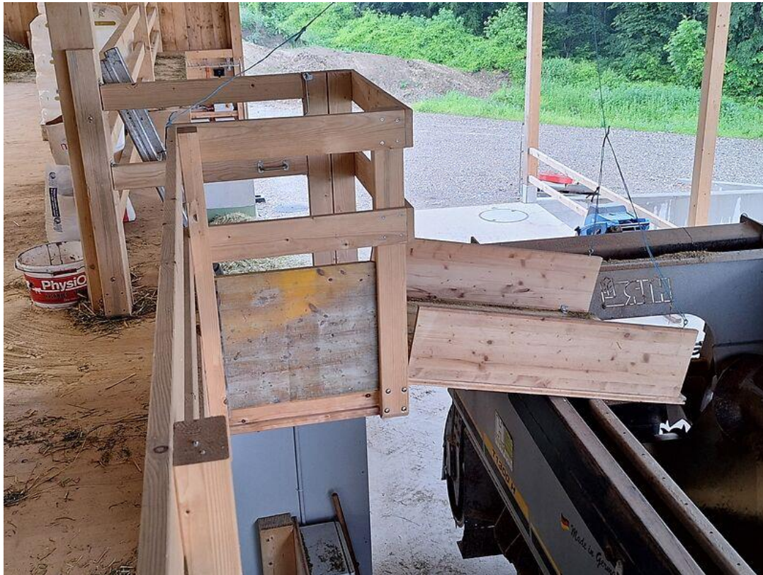
Sichere Abwurfstelle für manuelle Beschickung des Futtermischwagens
