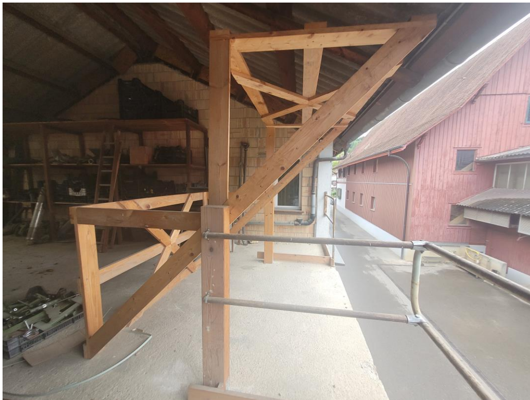
Warenschleuse im Wippensystem
