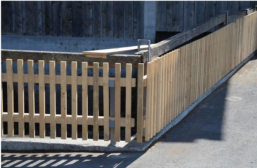
Garde-corps à l'épreuve des enfants avec éléments verticaux
