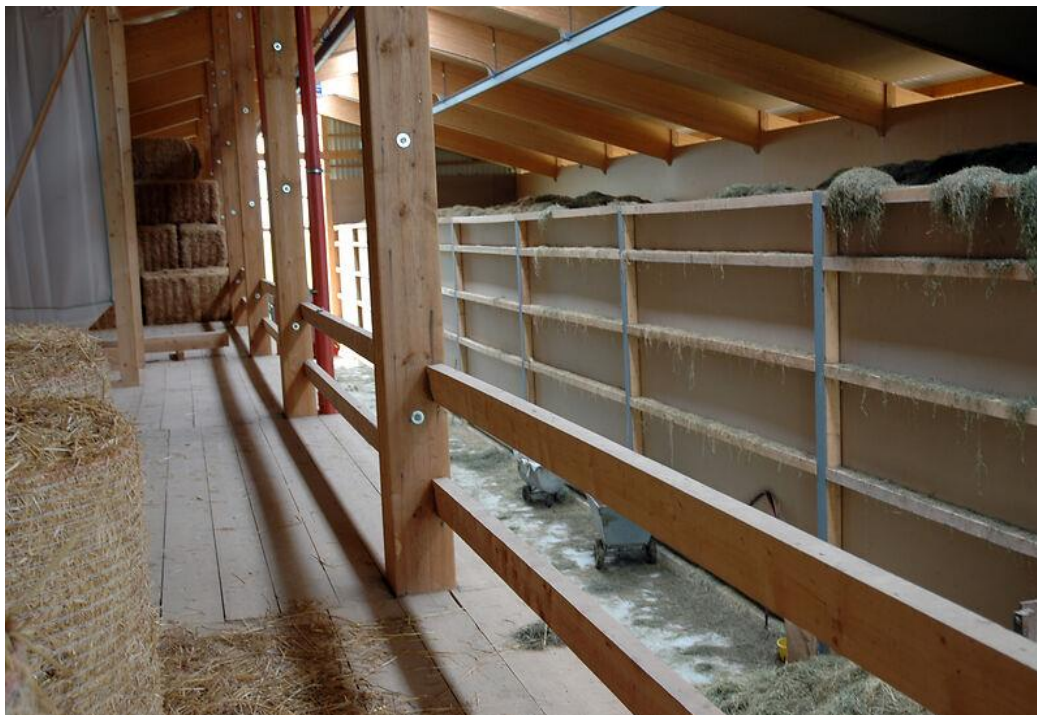
Ringhiera stabile su un soppalco di stoccaggio con parapetto e battuta alla ginocchia
