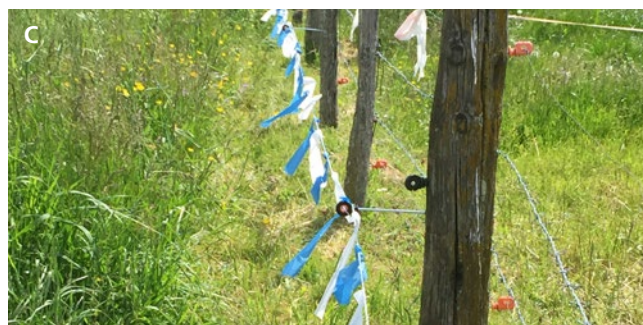
Foto C: Installation der Turbo Fladry Litze mit langen Isolatoren auf der Aussenseite. Ausmähen der Zaunlinie bei Bedarf.
